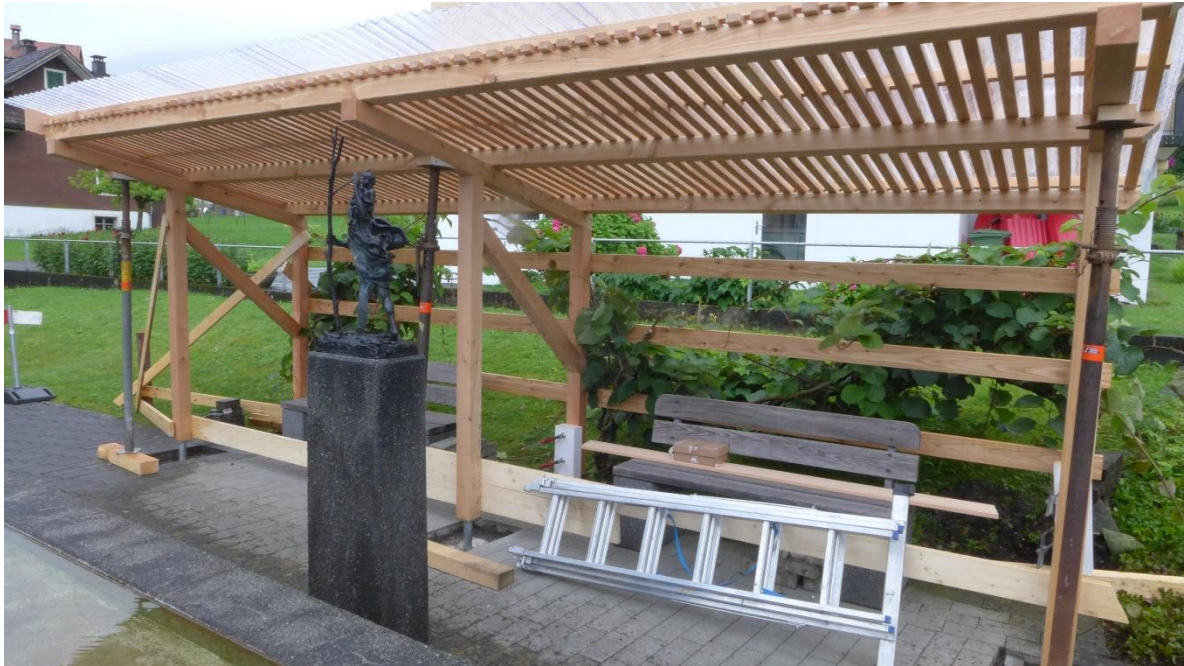
Neubau der vom Sturmtief Sabine zerstörten Pergola
